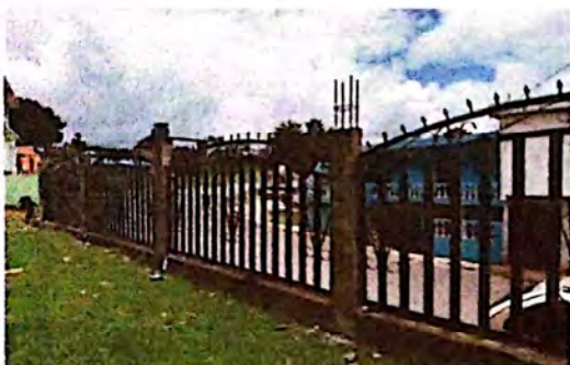
Foto 9: Sustrucción de baranda de metal
