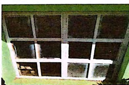
Foto 4: Sustitución de ventanas de metal y vidrios
