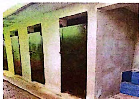
Foto 3: Sustitución de puertas
