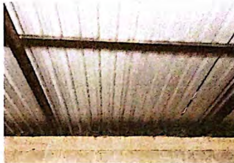
Foto 2: Sustitución de estructura de madera a metal
