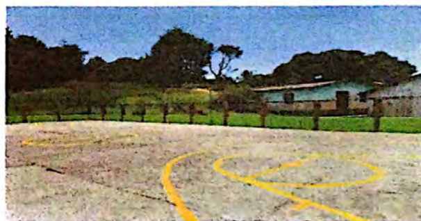
Foto 6: Pintura de muros exteriores e interiores
