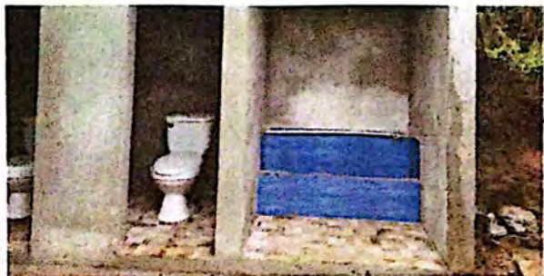
Foto 7: Sustrucción de Sanitarios
