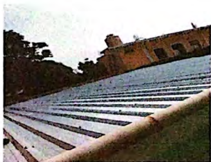
Foto 1: Sustitución de Lámina
